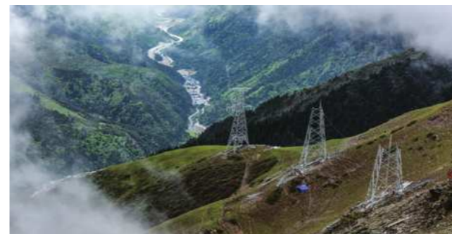
电力线档检测
