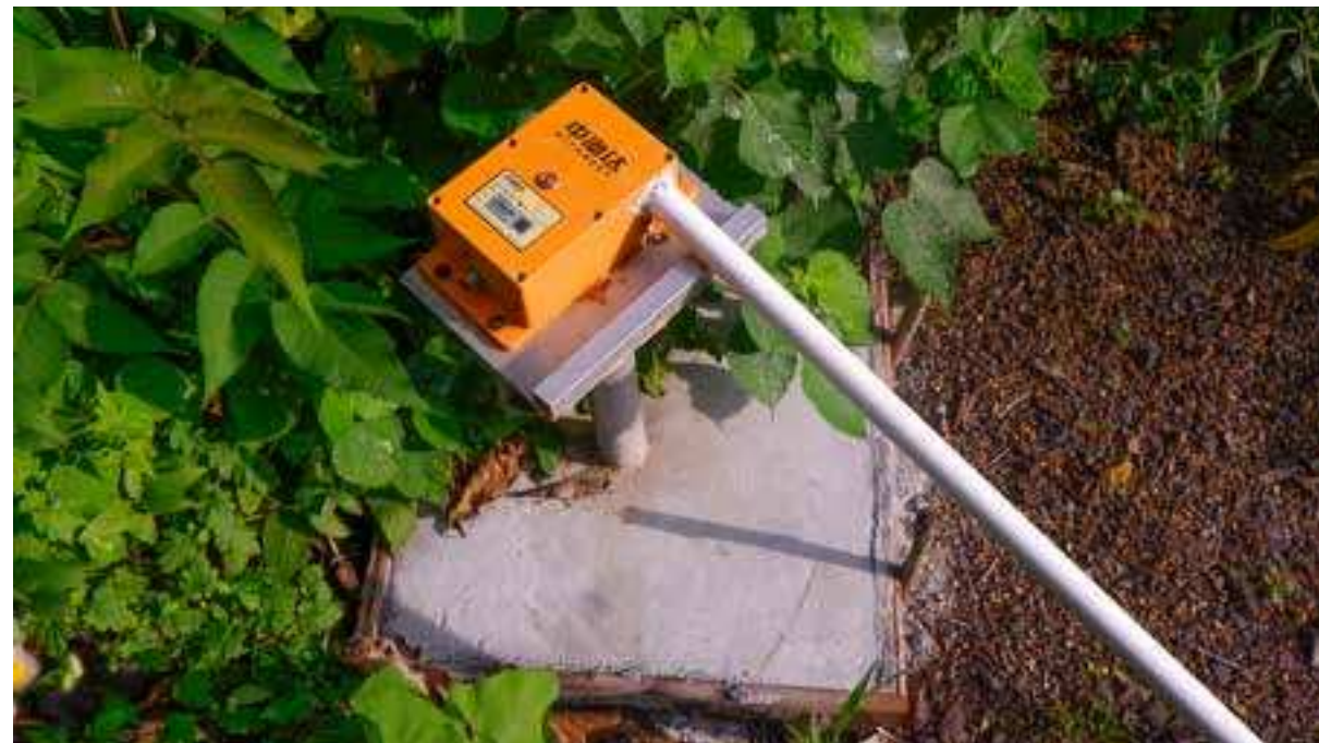
▲中海达普适化多维监测仪用于湖南省辰溪县地质灾害隐患点监测
