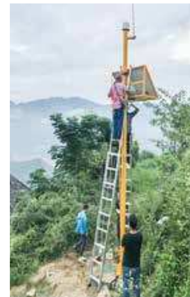
▲施工人员安装中海达地质灾害监测设备
