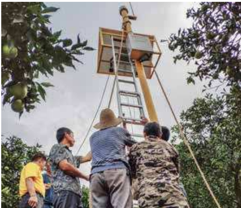
▲施工人员安装中海达地质灾害监测设备
