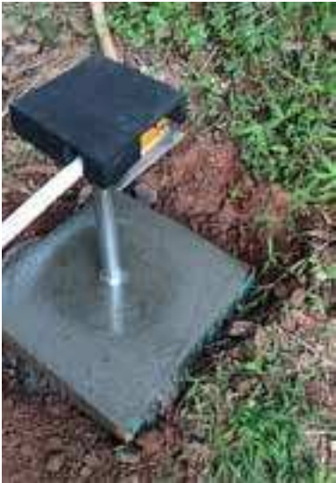
▲正在安装的中海达普适化监测设备
