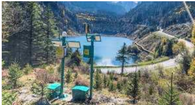
▲布设在九寨沟景区的中海达一体化GNSS监测站（左）、一体化雨量监测站
