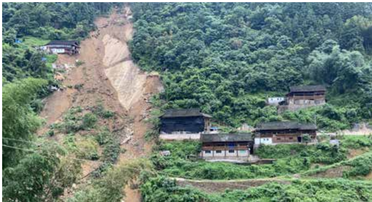
▲ 7月10日，黔东南州丹寨县扬武镇发生滑坡，由于中海达地质灾害监测设备及时预警，未造成人员伤亡
