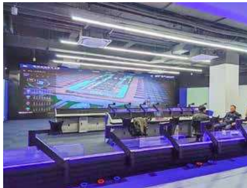
▲杭州东站警民联合全息三维系统部署在江干分局指挥大厅
