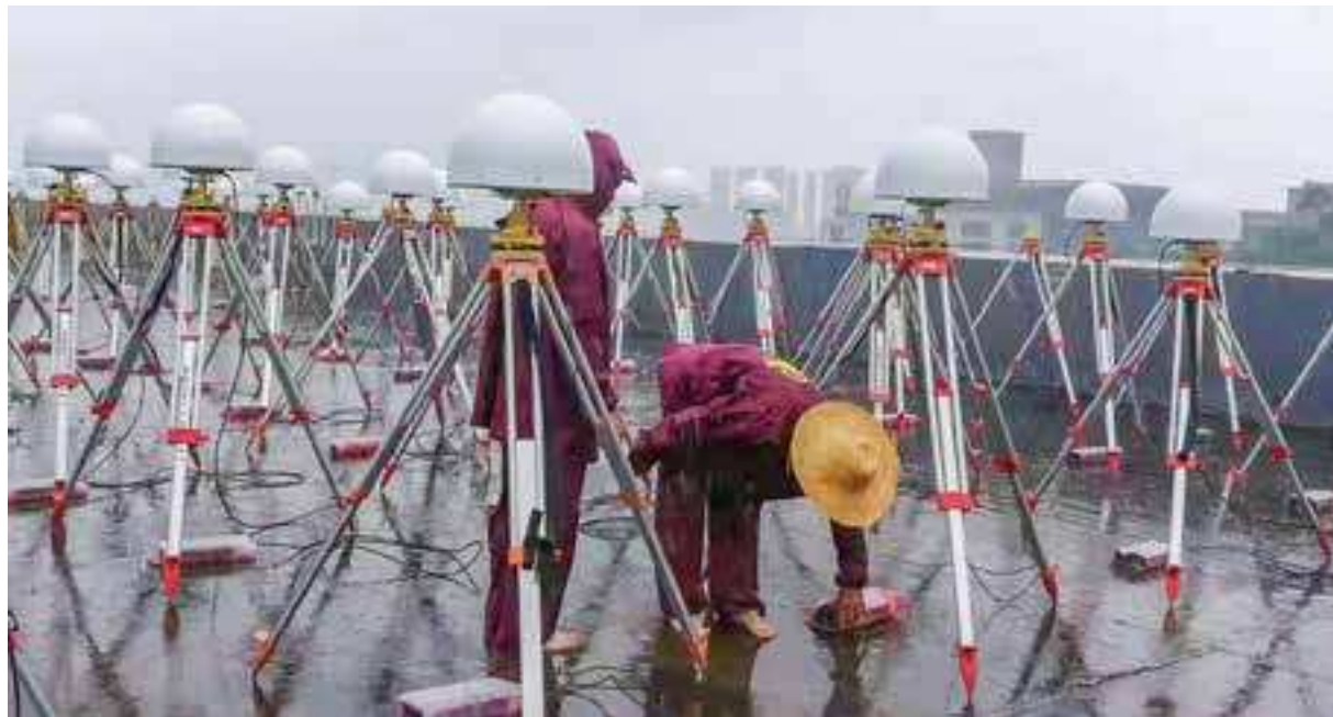
▲中海达工厂员工冒雨测试中移动项目设备
